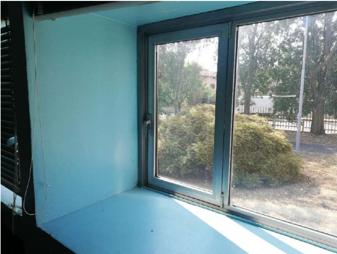
Particolari finestre da interno
