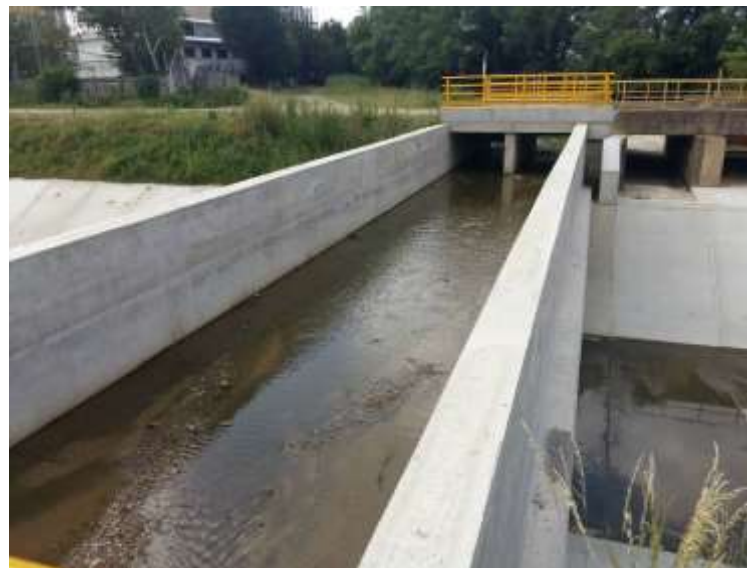
Figura 7– Ponte Canale CSNO
