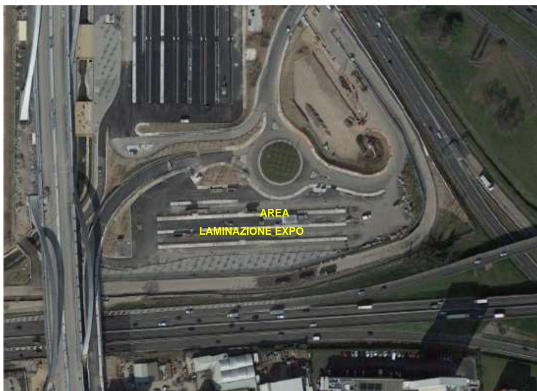
Figura 5– Area di laminazione all'interno del sito EXPO (vasca interrata)
