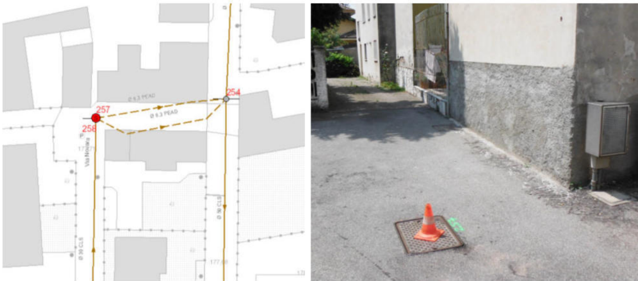
Figura 6: Impianto di sollevamento con relativa ripresa fotografica oggetto di intervento strutturale IS01
