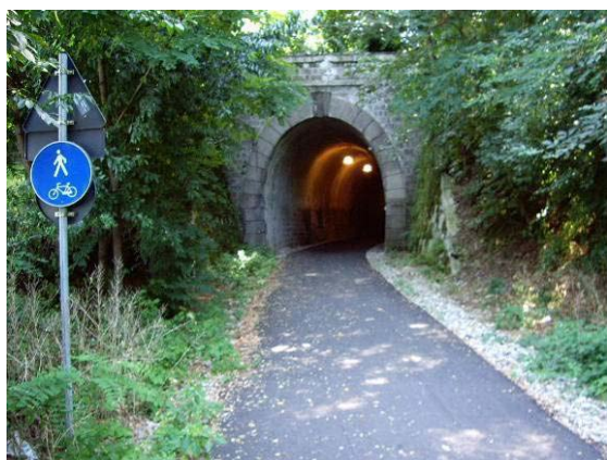
Ponte Tresa (Va), pista ciclopedonale realizzata sul sedime di un tracciato ferroviario dismesso.
