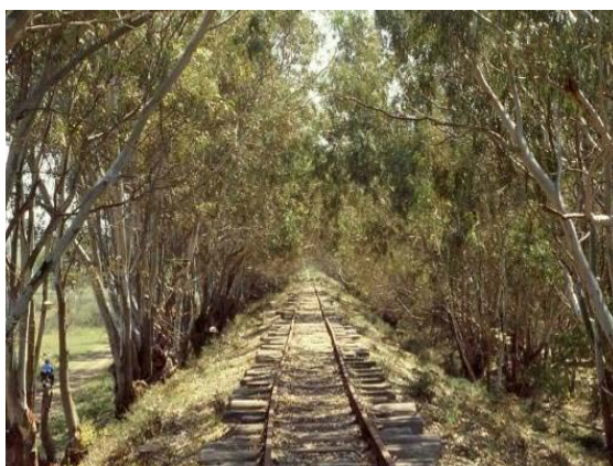
Menfi e Portopalo. Proposta di riconversione delle linee ferroviarie dismesse in Sicilia; dettaglio di un tratto di ferrovia dismessa che riutilizzata per realizzare una pista ciclabile
