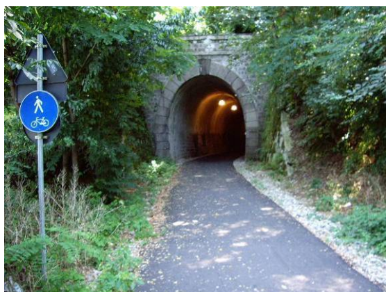
Ponte Tresa (Va), pista ciclopedonale realizzata sul sedime di un tracciato ferroviario dismesso.
