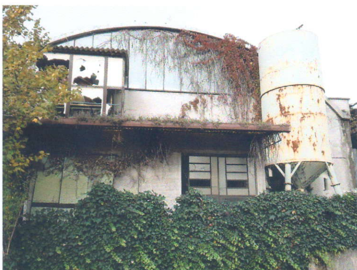
Foto 8: foto dell'attuale edificio che verrà demolito visto da via Toti
