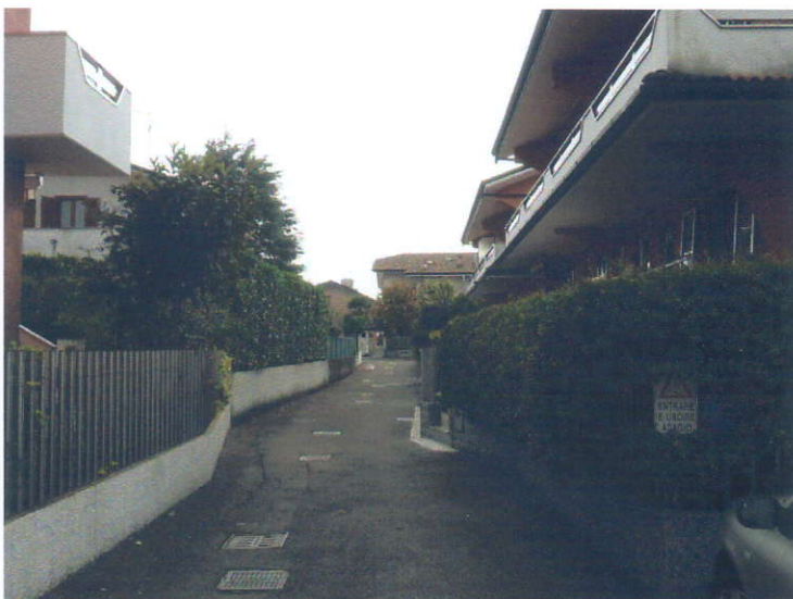
Foto 11: foto dei confini con edifici residenziali lato Sud dall'accesso da via Toti
