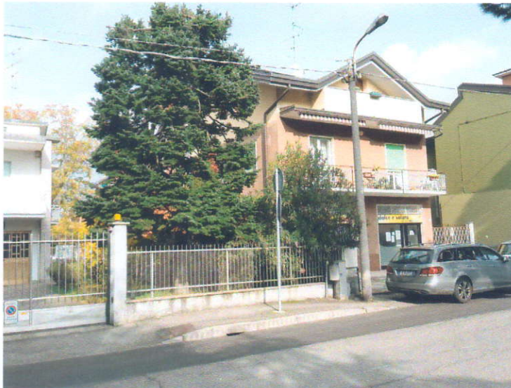
Foto 4: foto dei confini con edifici residenziali lato Nord oltre via dei Mille con al piano terra attività commerciali
